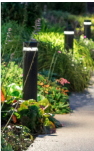
Pullert belysning ved stiforløb, Den Grønne Plads og grønne gårde
